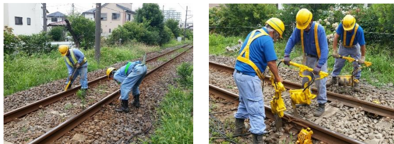
(参考・線路の点検の様子)
